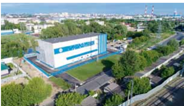
Рис. 1. Подстанция 110 кВ «Портовая»
