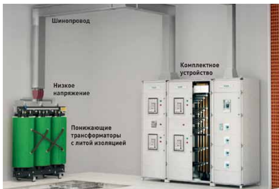
Рис. 2. Установка сухого трансформатора внутри производственного помещения
