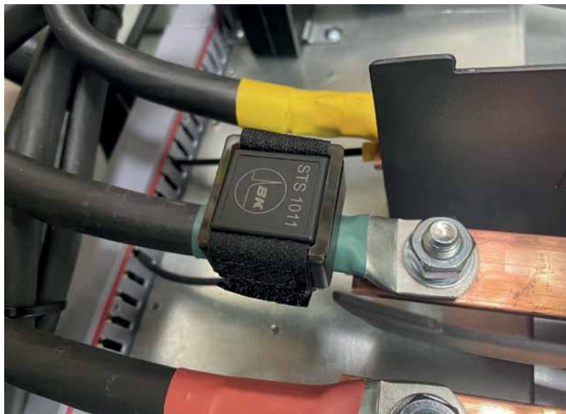
Рис. 3. Установка датчика STS 1011 на кабельный наконечник
