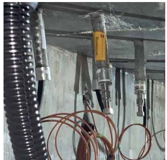
Рис. 5. Распределенный датчик температуры и нагревательный кабель в трубках: фото с объекта
