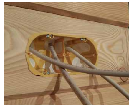
Рис. 3. Электромонтажная коробка из огнестойкого пластика с резиновыми мембранами в строительстве деревянного дома
