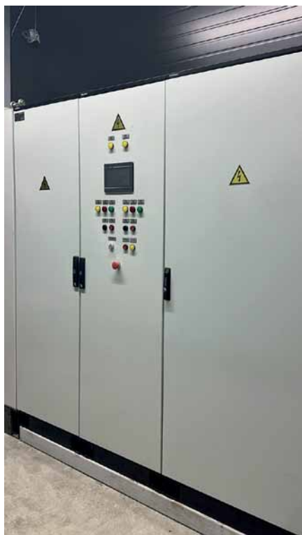
Рис. 1. Система АВР на базе оборудования Митра (Mitra): а – шкаф с панелью оператора; б – элементы системы АВР внутри шкафа
