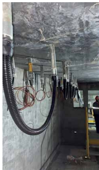
Рис. 5. Распределенный датчик температуры и нагревательный кабель в трубках: фото с объекта
