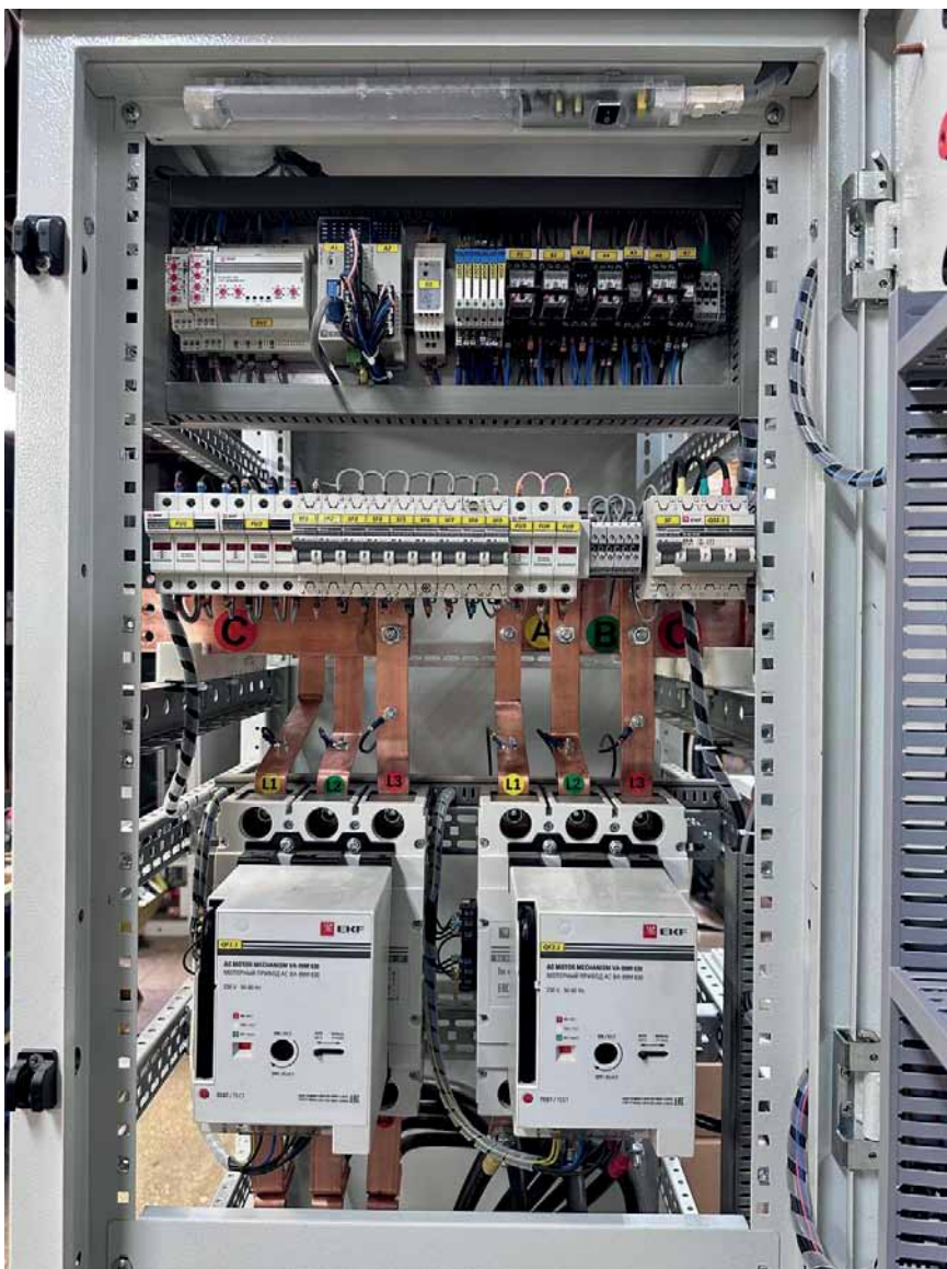
Рис. 2. АВР в системе энергоснабжения хлебозавода
