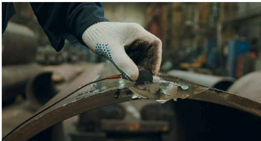
Рис. 3. Проведение дефектоскопии сварных швов
