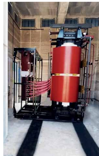
Рис. 1. Сухой трансформатор с литой изоляцией ООО «Проектэлектротехника»: 4-й габарит, мощность 10 МВА, напряжение 35/10 кВ
