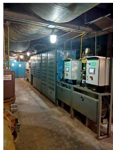
Рис. 3. Монтаж шкафов ШУГ САУГ КА № 7 ЭК НиГРЭС г. Балахна
