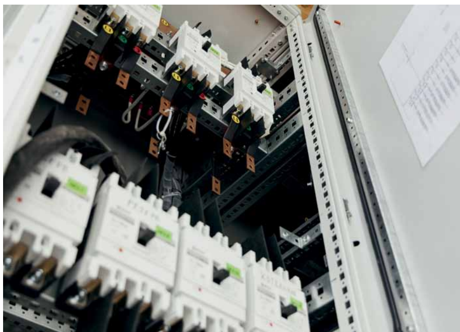
Рис. 3. ГРЩ для горного отеля на базе оболочки AleSta
