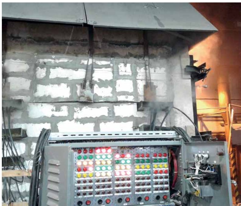
Рис. 1. Испытания огнестойкой кабельной линии ELTROS OKLine в печи
