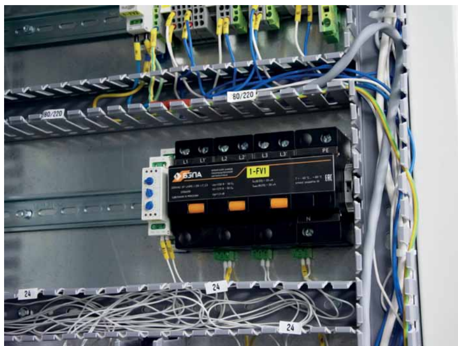
Рис. 1. Силовой УЗИП БЗПА: внешний вид
