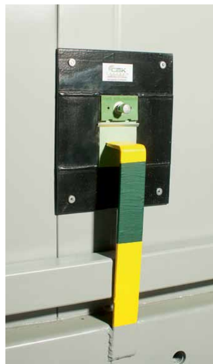
Рис. 5. Вывод полосы заземления
