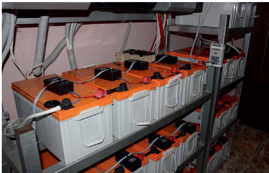
Рис. 4. Система балансировки на 20 свинцовых аккумуляторах: последовательно-параллельное соединение, общее напряжение системы 48 В. Фото из личного архива автора
