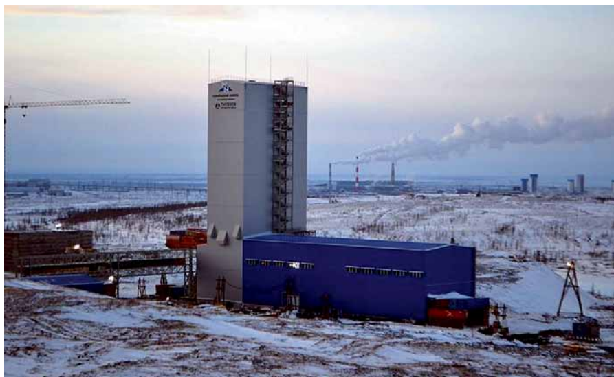
Рис. 1. Молниеприемники ELMASST® на надшахтном сооружении
