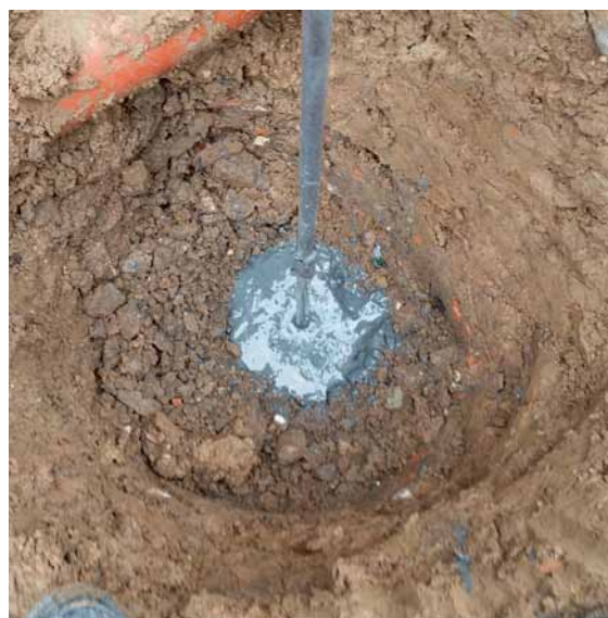
Рис. 2. Элементы вертикальной системы заземления: а – электропроводящий состав для монтажа заземляющих устройств; б – вертикальные заземлители
