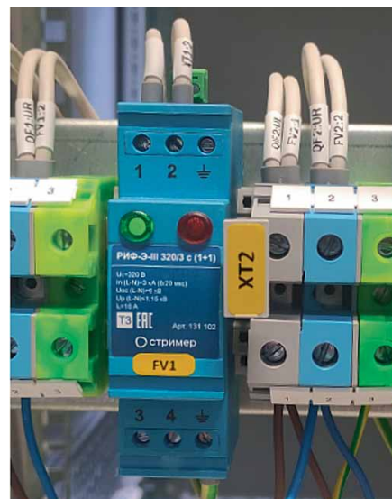
Рис. 1. Монтаж УЗИП на DIN-рейку
