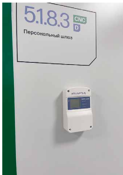
Рис. 5. Проводной узел «Пирс-SAN»: примеры скрытого монтажа для чистых помещений
