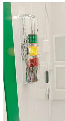
Рис. 3. Световая колонна, управляемая узлом «Пирс-CAN»
