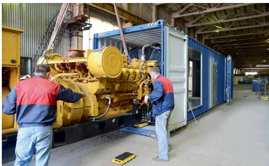
Рис. 3. Установка ДГУ в блок-контейнер на производственной площадке ГК ТСС
