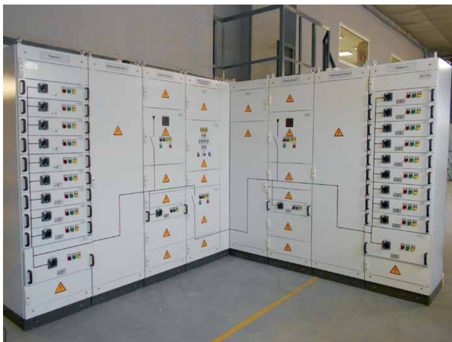
Рис. 1. НКУ «ЭСКОН-М» с выкатными элементами
