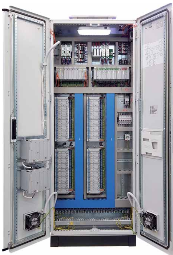
Рис. 1. Типовой шкаф УСО на базе модулей МКСО
