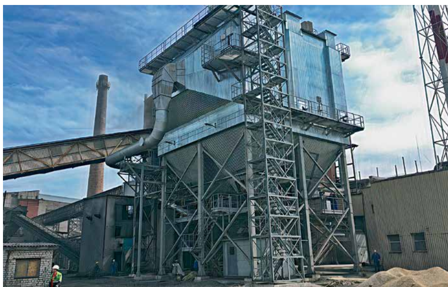
Рис. 1. Электрофильтры «ФИНГО»: а – на Бийской ТЭЦ; б – в г. Кивиыли, Эстония
