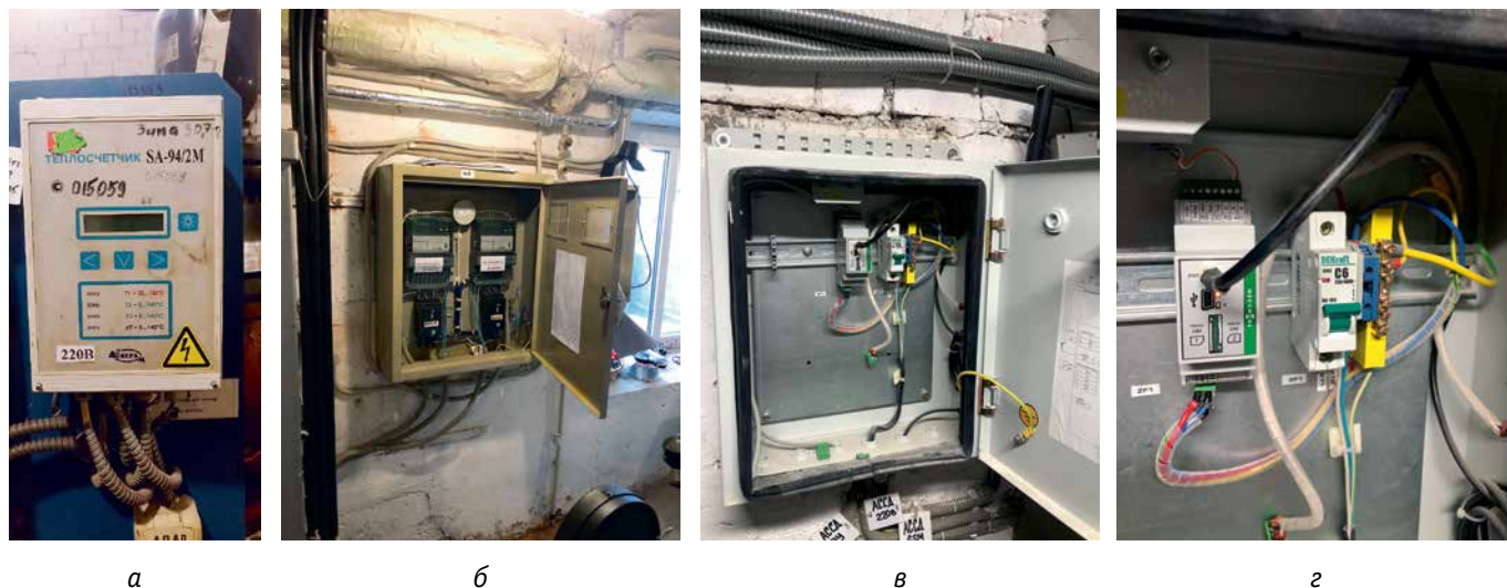
Рис. 2. Точки учета с дистанционным сбором показаний: а – теплосчетчик; б – счетчики электроэнергии; в, г – подключение всех точек учета к одному модему PROMODEM GSM-125.79M
