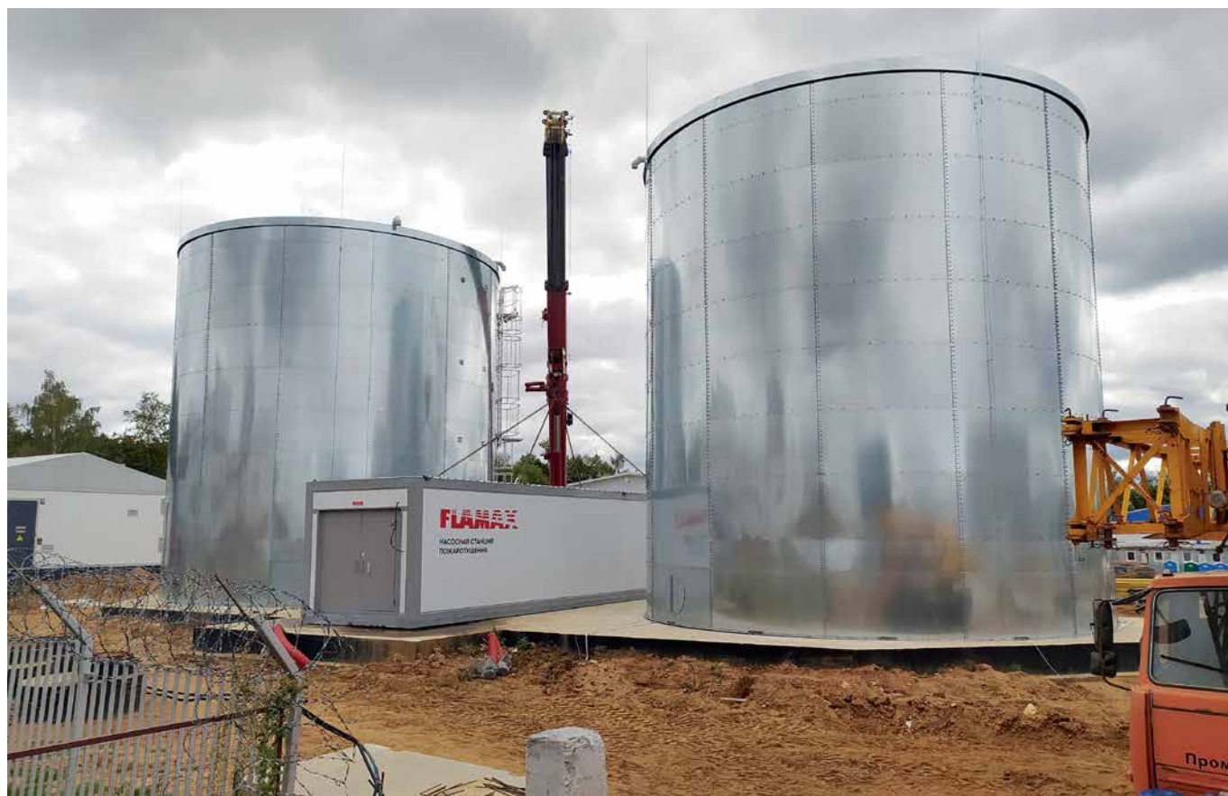
Рис. 1. Комплексная система пожаротушения FLAMAX: резервуары и насосная станция с системой автоматизации
