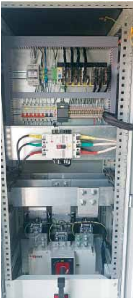
Рис. 14. Система управления микроклиматом технологического комплекса для майнинга криптовалют на базе PRO-Logic и PRO-Screen
