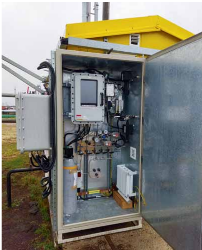
Рис. 2. Аналитический комплекс для индикации ХОС в нефти
