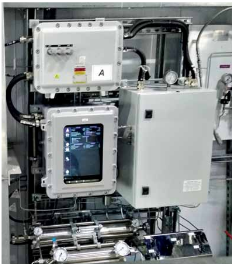
Рис. 1. Измерительный комплекс для анализа нестабильного газового конденсата (НГК)
