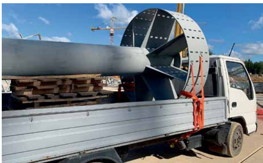
Рис. 2. Элементы конструкции и отделки Главного храма Вооруженных сил РФ, обработанные составом класса Zinker
