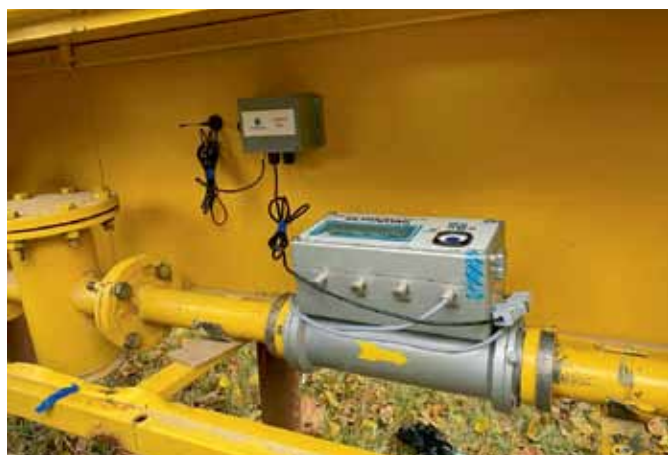
Рис. 5. Подключение автономного газового корректора к батарейному модему PROMODEM GSM-125.00 М для периодического опроса из диспетчерской через интернет сотового оператора
