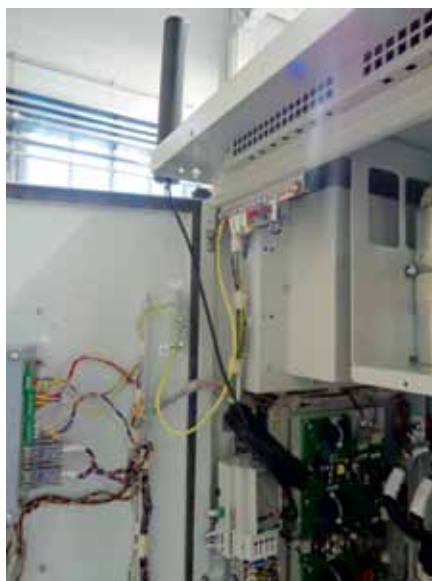
Рис. 1. Подключение контроллера АСУ ТП (RS-485) и измерителя входного напряжения (RS-232) к 2-интерфейсному модему PROMODEM GSM-485-232-AC-UPS со встроенным аккумулятором
