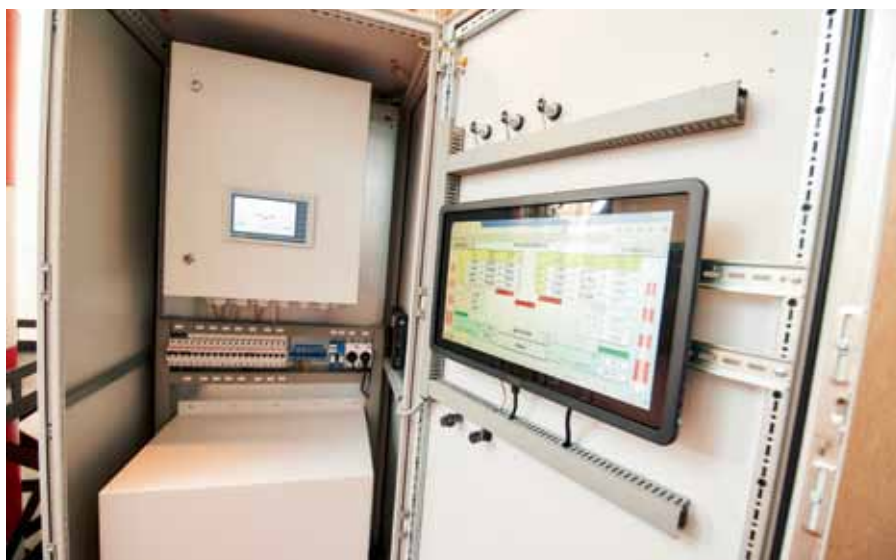
Рис. 5. Многофункциональный комплекс телеметрии «Софт:Сигнал»-Ш-С-СИ v.Eco
