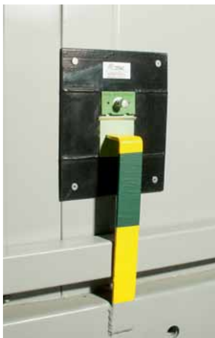
Рис. 4. Вывод полосы заземления
