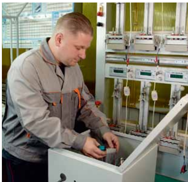
▲ Работа в цехе № 2
