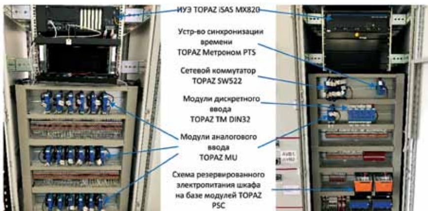
Рис. 4. Пример расположения элементов комплекса ТОРАЗ РАС на ПС 110/10/6 кВ «Бирюлево»
