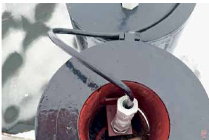
Рис. 3. Монтаж измерительного комплекта внутри скважины
