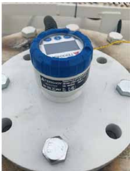
Рис. 3. Уровнемер «ТИТАН-270У», установленный на объекте
