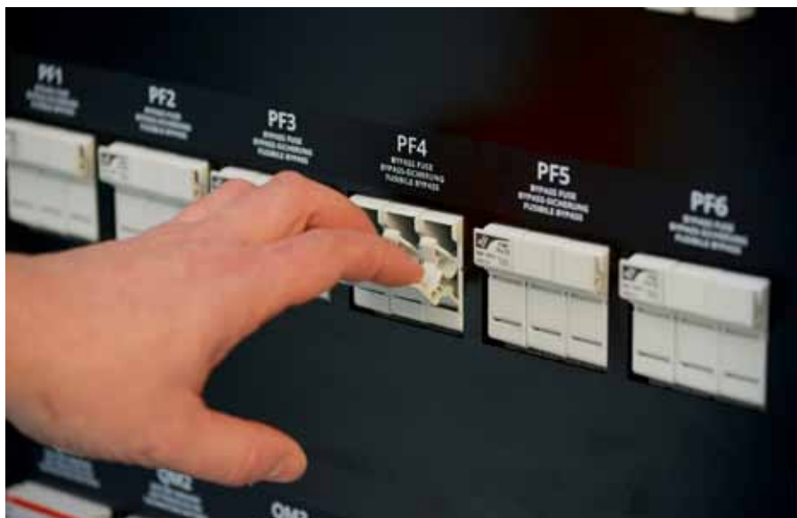
Рис. 4. Замена предохранителя PF4
