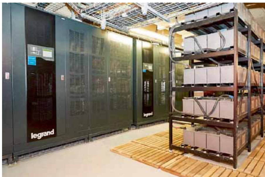
Рис. 3. ИБП Legrand Keor HP с внешним батарейным массивом
