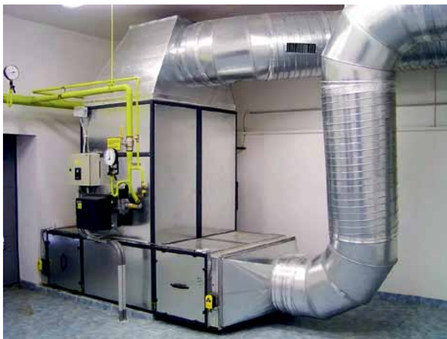
Рис. 5. Газовоздушный теплогенератор
