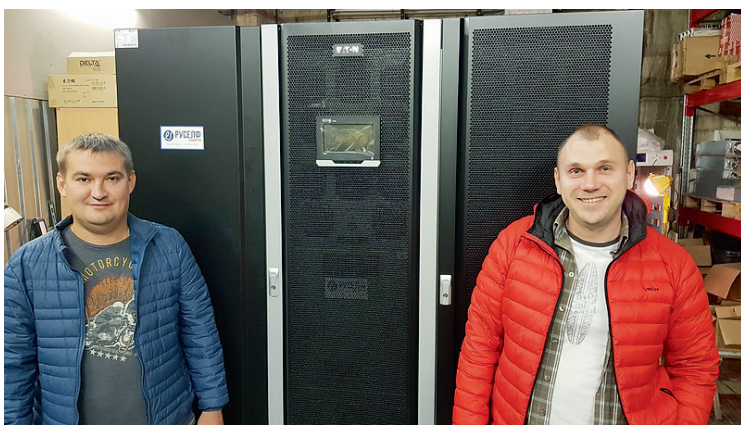
Рис. 1. На космодроме «Восточный»: специалисты «РУСЕЛФ ЭНЕРГО» доставили ИБП Eaton 93PM на объект
