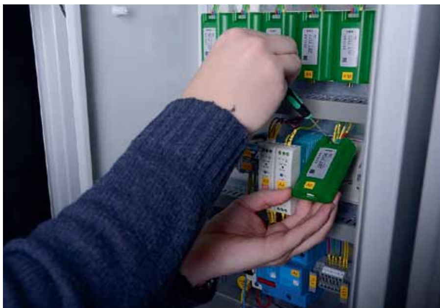
Рис. 2. Система на базе ZET 7251-N PRO подключается через преобразователи интерфейсов и легко масштабируется
