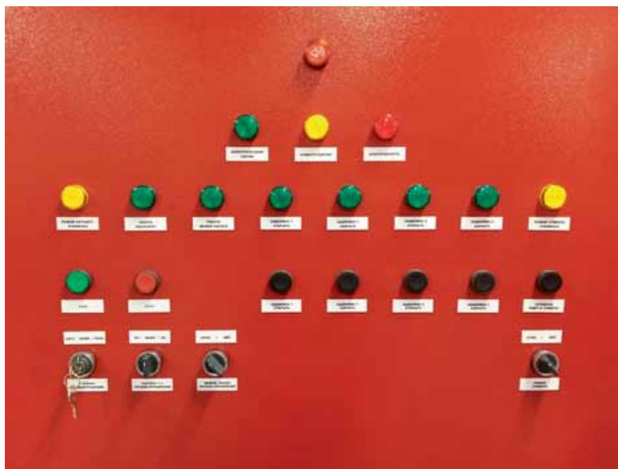
Рис. 2. ЩУЗ-ГидроСи-ПТ: фронтальная поверхность с кнопками управления и индикаторами
