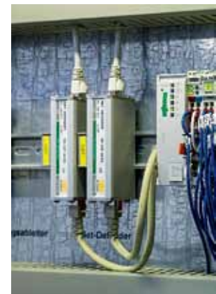
Рис. 2. Защита телекоммуникационного оборудования с помощью устройств NetDefender
