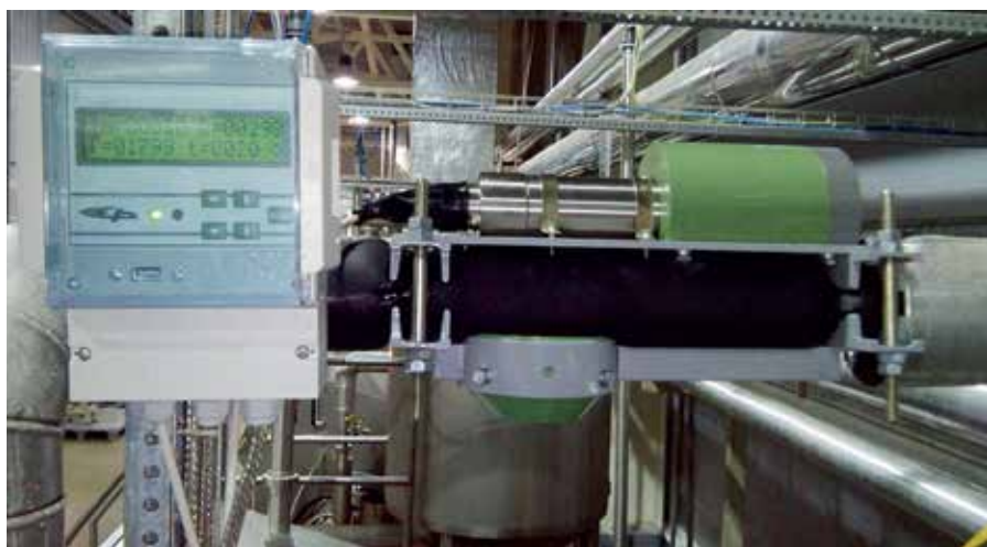
Рис. 2. Приборы «Экофизприбор» можно применять без радиационной защиты, устанавливая в любых удобных для работы местах
