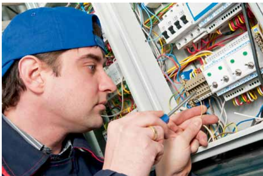
Рис. 5. Монтаж и пусконаладочные работы
