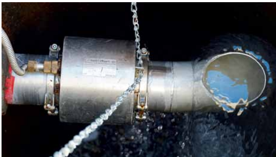
Рис. 2. Электромагнитный расходомер для учета сточных вод «Взлет СК»
