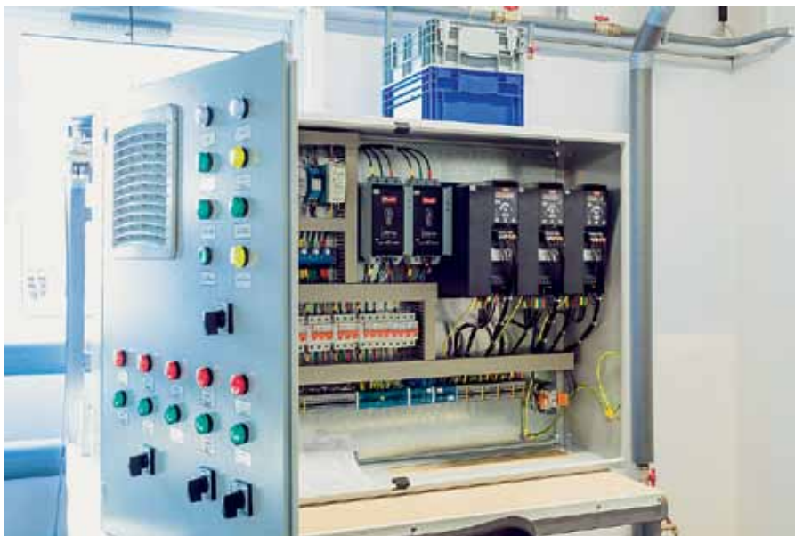
Рис. 2. Щит управления и защиты СИНТО для насосной станции с частотным регулированием
