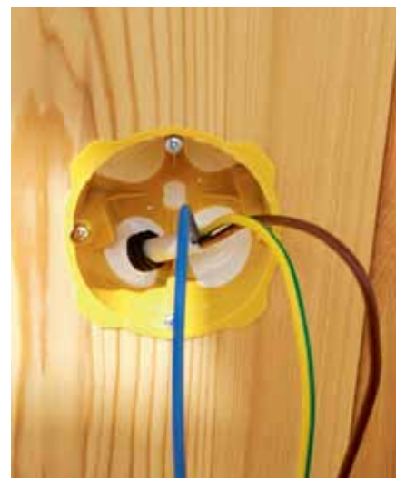
Рис. 3. Монтаж электропроводки с помощью подрозетника серии KPL
