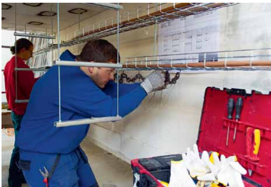
Рис. 1. Во время испытаний огнестойких кабельных каналов Koros
