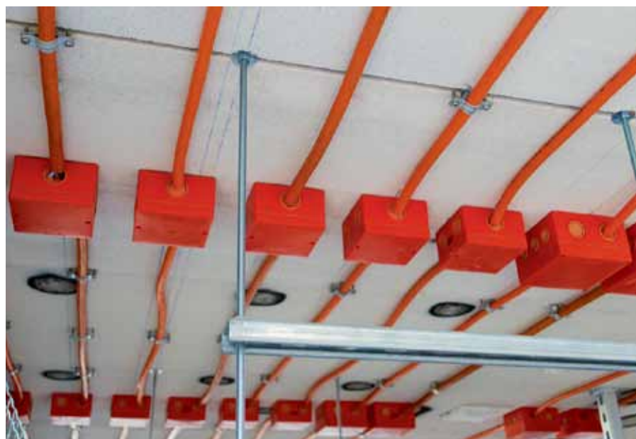
Рис. 3. На испытаниях огнестойкой продукции Koros: пластиковые кабельные каналы, электромонтажные коробки и стяжки
