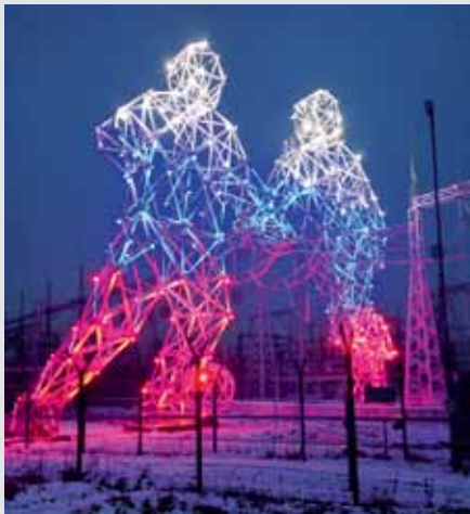
▲ Опоры ЛЭП на Пермской ГРЭС в виде футболистов
