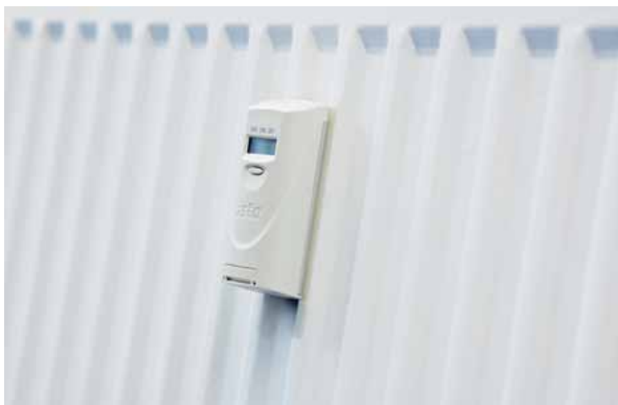
Рис. 4. Распределитель затрат на отопление «Доприно 3»
