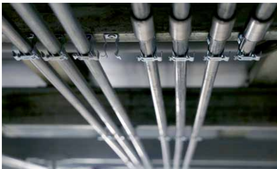
Рис. 2. Система металлических труб для электропроводки «Cosmes»
