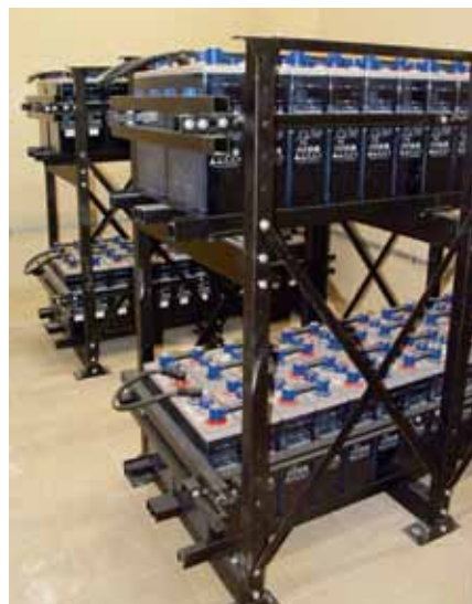
Рис. 4. АБ на стеллажах
